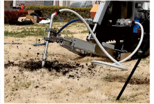
圧縮空気と土を弾き飛ばして掘削します
